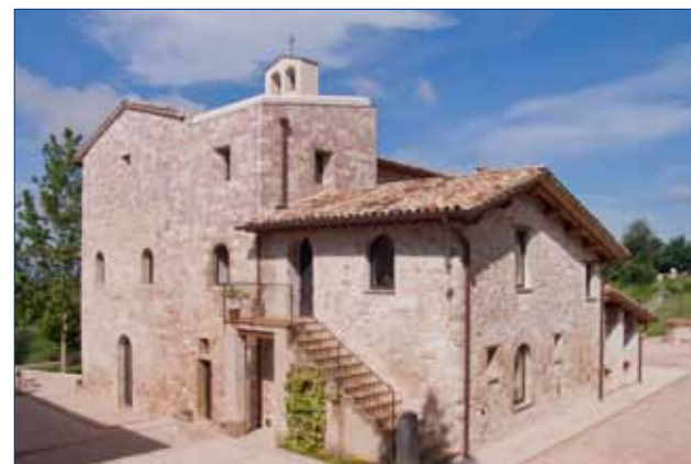
Veduta dell'edificio principale di San Masseo
